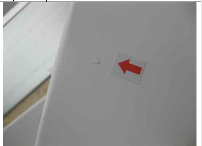
38) Minor: poor surface
