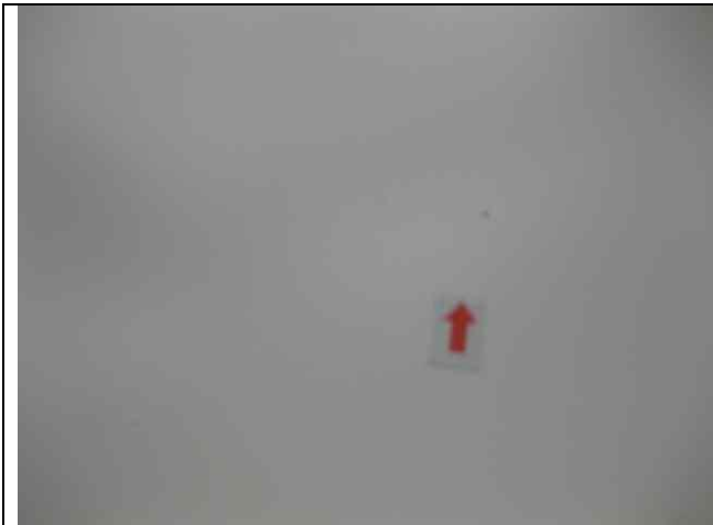
35) Minor: poor surface
